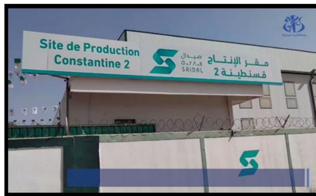
Figure 7 Site de production de Constantine 2.
